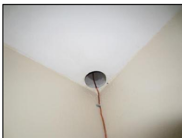
Photo N° 1145 AMIANTE CIMENT -- PALIERS RDC à +4 Plafonds Fourreau
